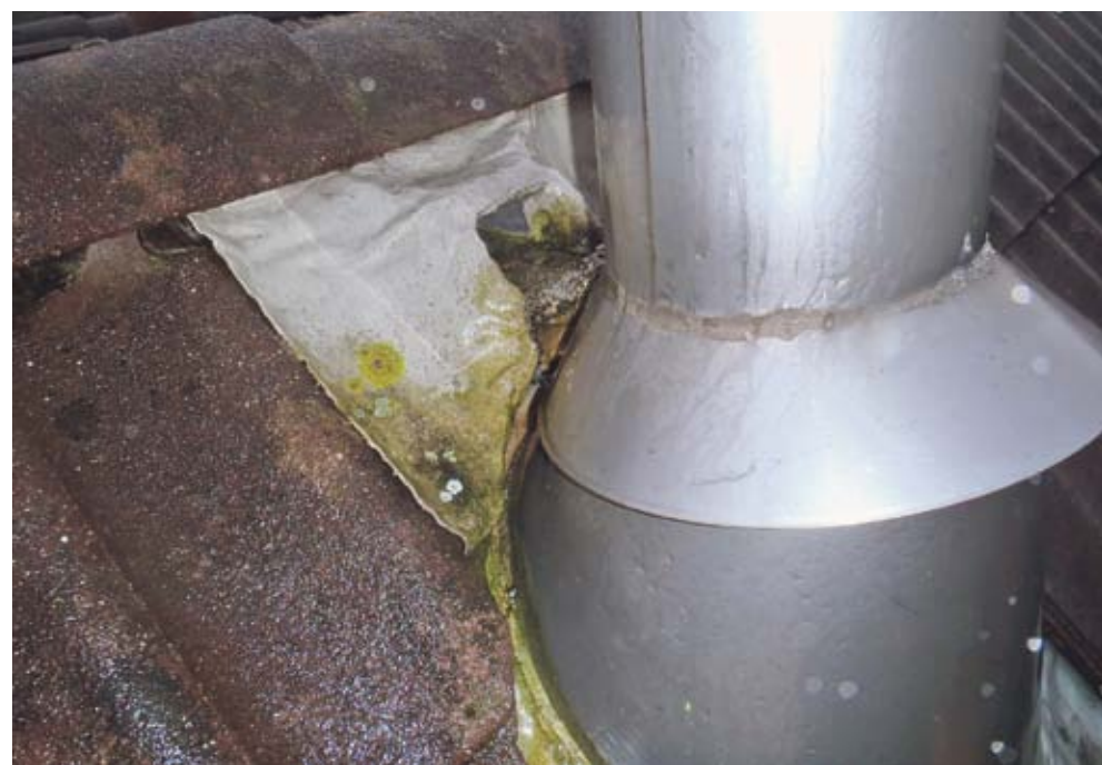
Foto 04. Schoorsteen met hemelwaterafvoer.
