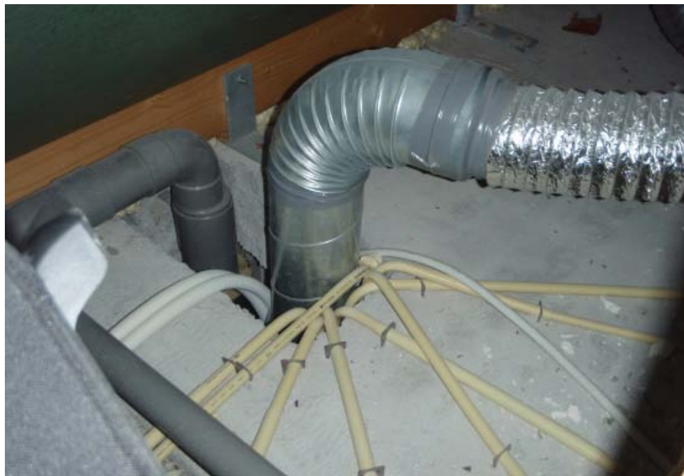
Bovenzijde schacht op zolder.
