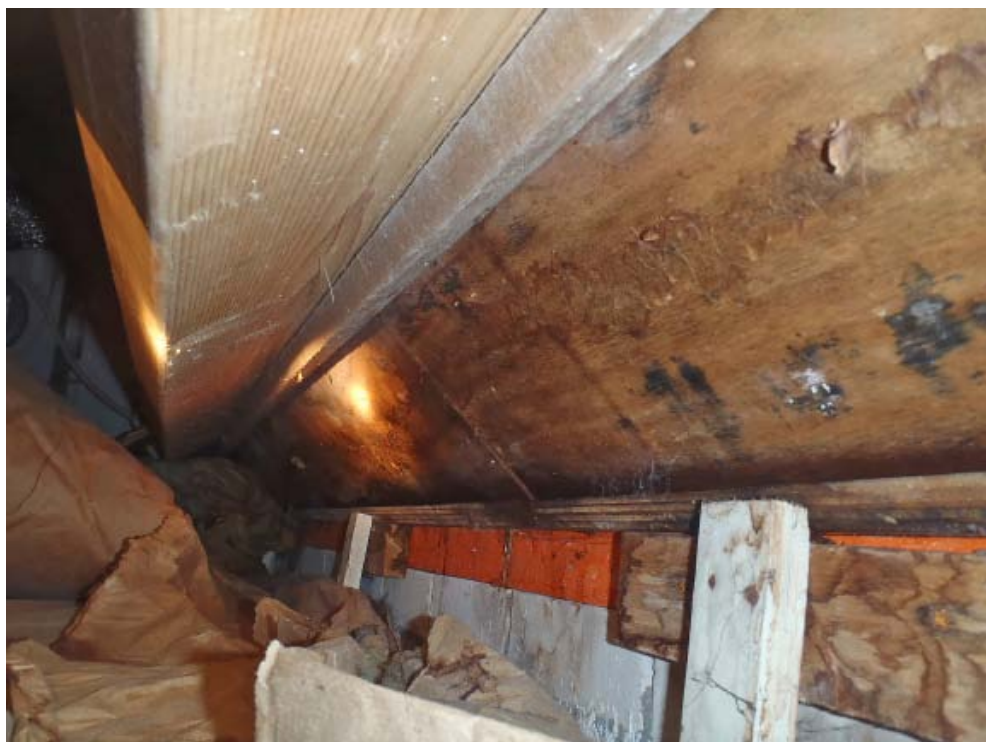
Foto 1. Zakgoot constructie vanaf de zolder.
