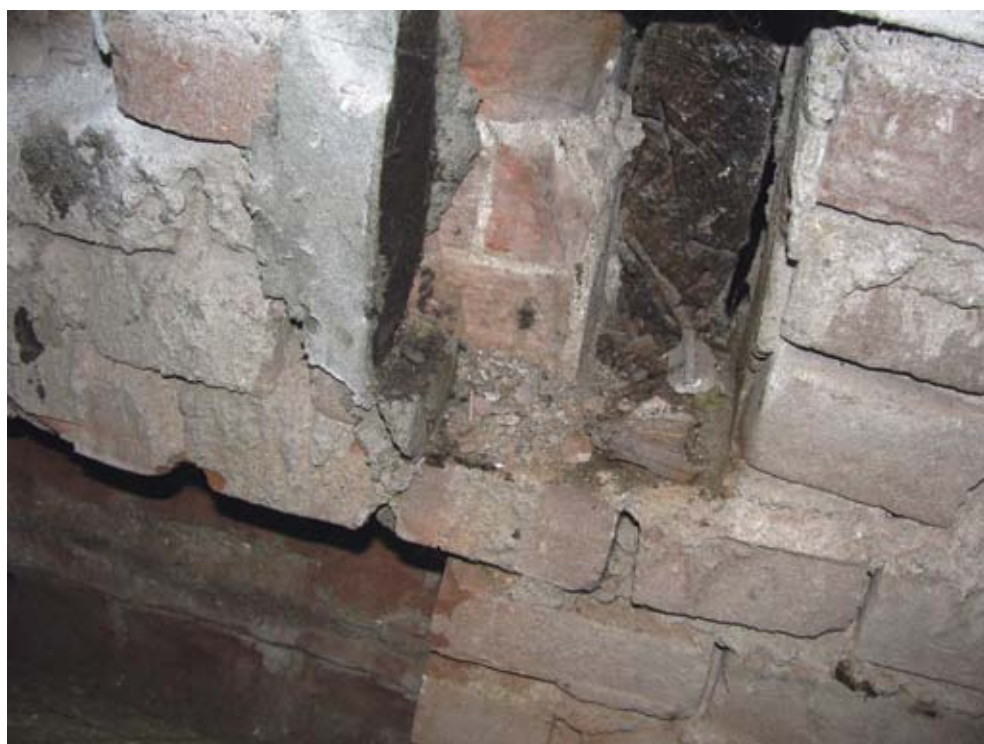
Foto 03. De gaten en balkkoppen in de bouwmuur.
