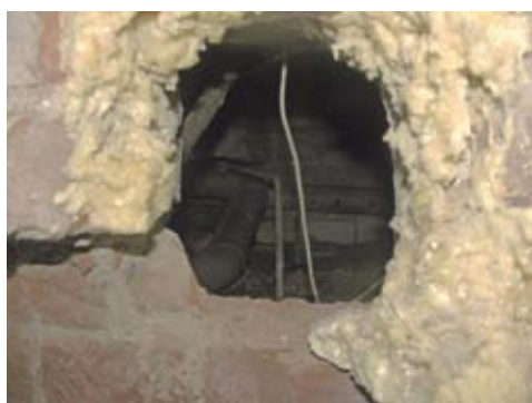
Foto 02. De gaten en balkkoppen in de bouwmuur.
