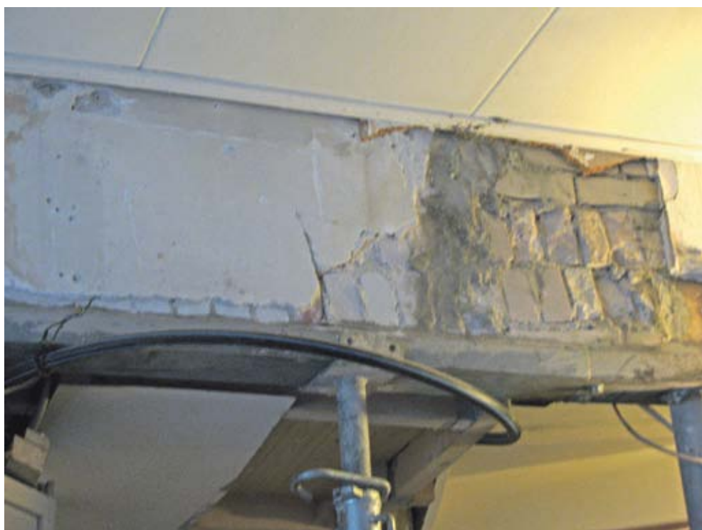
Foto 01. De gasleidingen onderstempeling.
