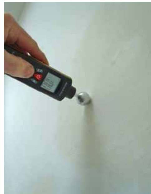
Foto 1. Vochtmeting van het stucwerk.
