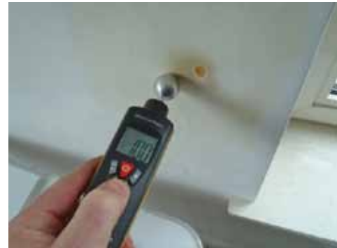
Foto 2. Vochtmeting van het stucwerk.
