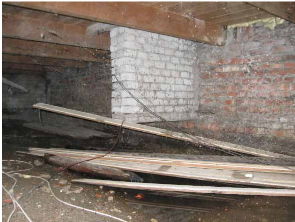
Foto 4. Bij het uitvoeren van het voorgeschreven herstel moet er rekening worden gehouden met het witte dwarswandje.
