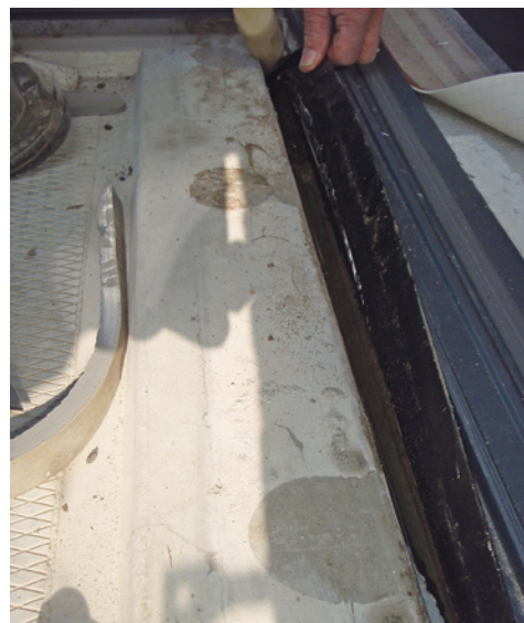
Verwijderde kitvoeg en zicht op gootje.
