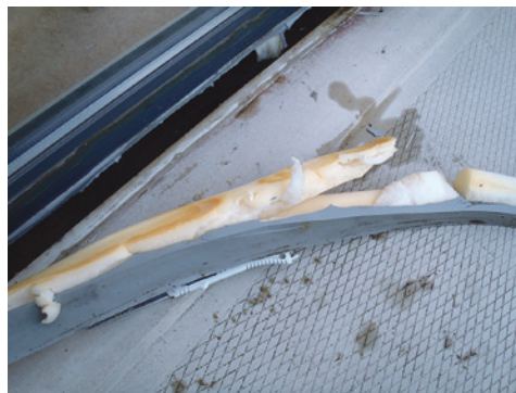
Verwijderde kitvoeg op rugvulling.
