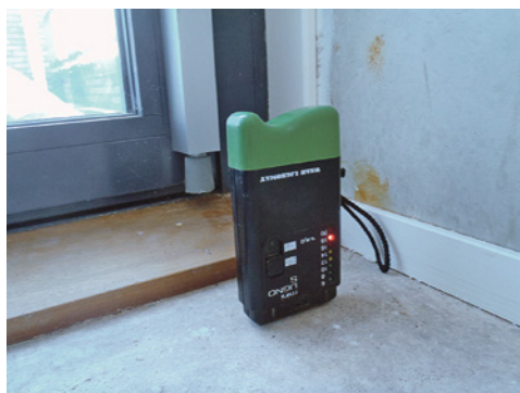
Meting vochtigheid vloer woonkamer nabij balkondeur.
