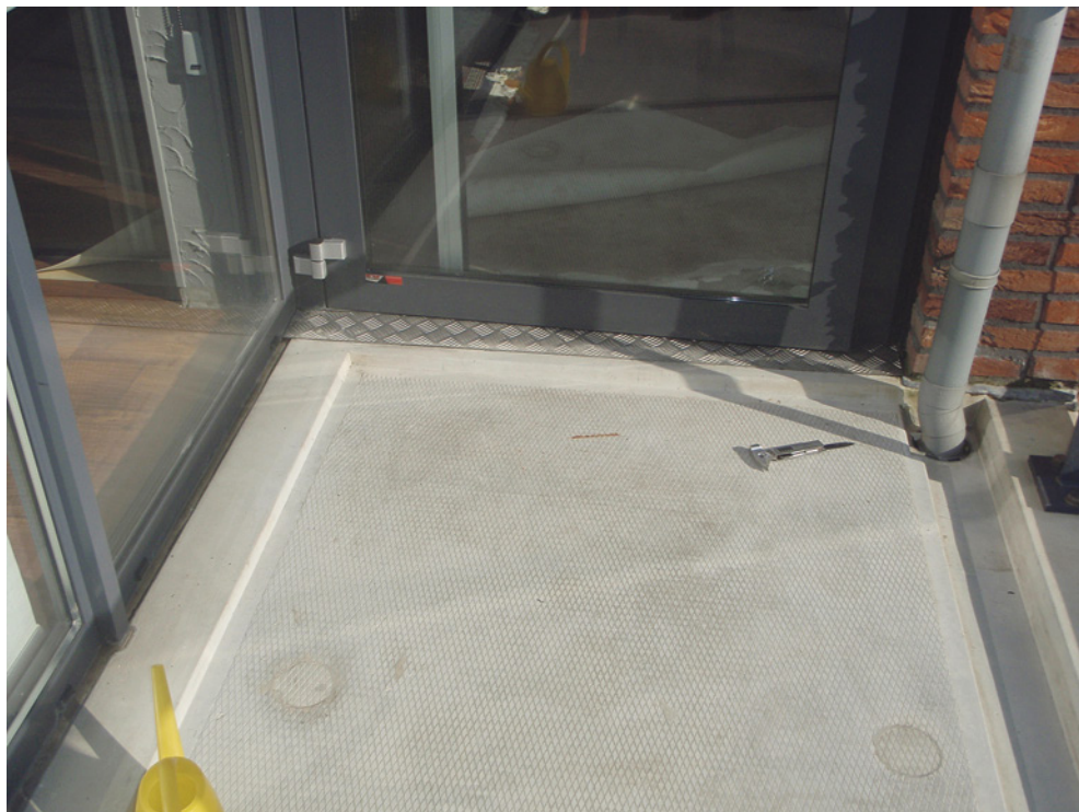
Onderdorpel vanaf balkon gezien.
