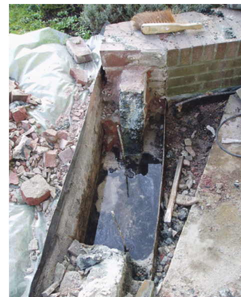
Plaatselijk verwijderde scheidingsmuur.
