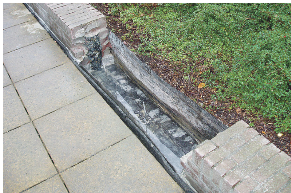
Plaatselijk verwijderde scheidingsmuur.
