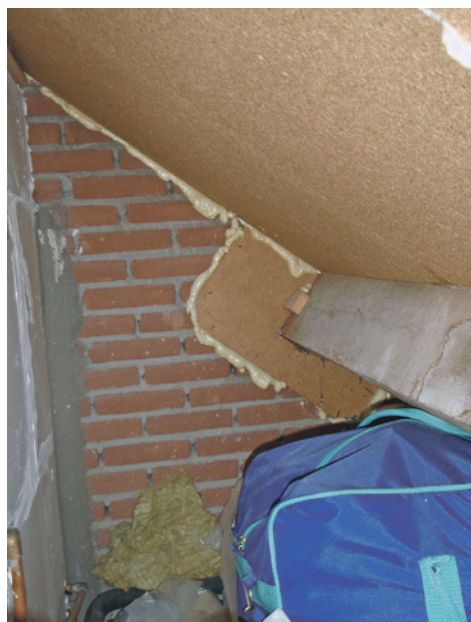
Alle kieren rondom het dak zijn voorzien van PUR-schuim.
