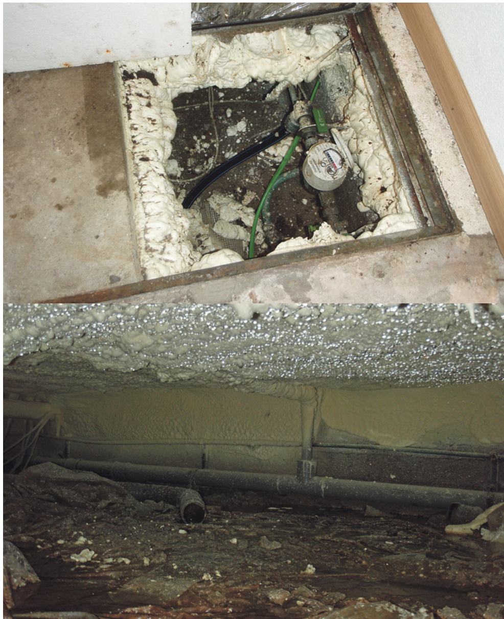
Kruipruimte isolatie door middel van PUR-schuim.
