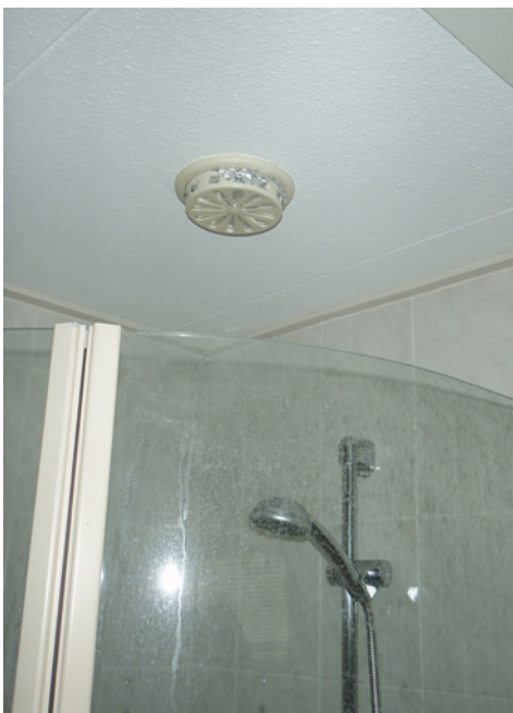
Alle ventilatie openingen afgedicht.
